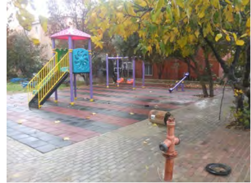
Kauçuk Zemin Yapılması
